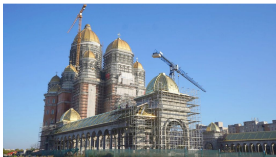
Stavebné práce pokračujú.
